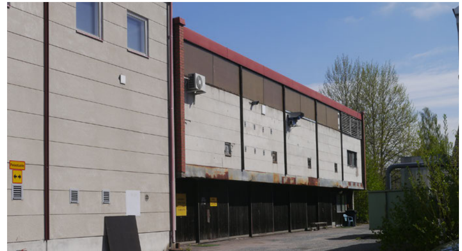
Alkuperäisen osan eteläjulkisivu ja liittyminen laajennusosaan
