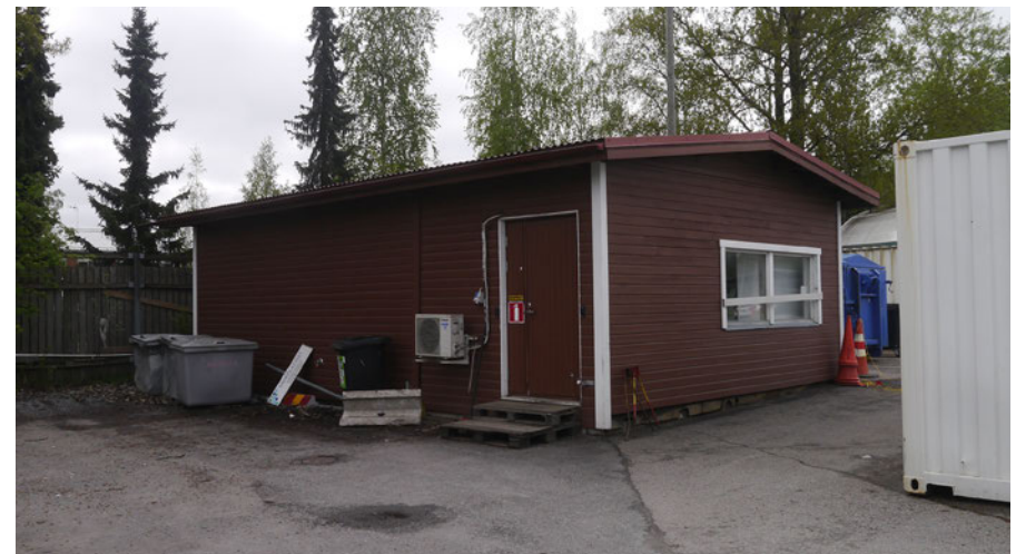
Vanha toimistorakennus luoteesta
