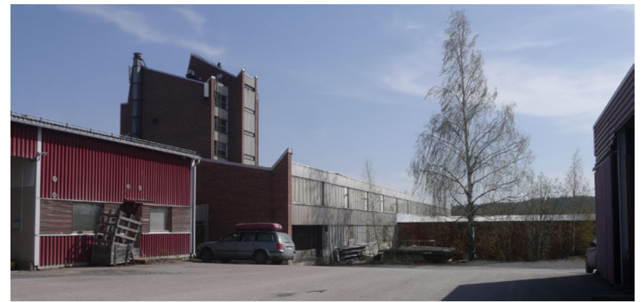
Konekorjaamo luoteesta. Etualalla pohjoinen ja taustalla läntinen, profiilipeltiseinäinen lisäsiipi
