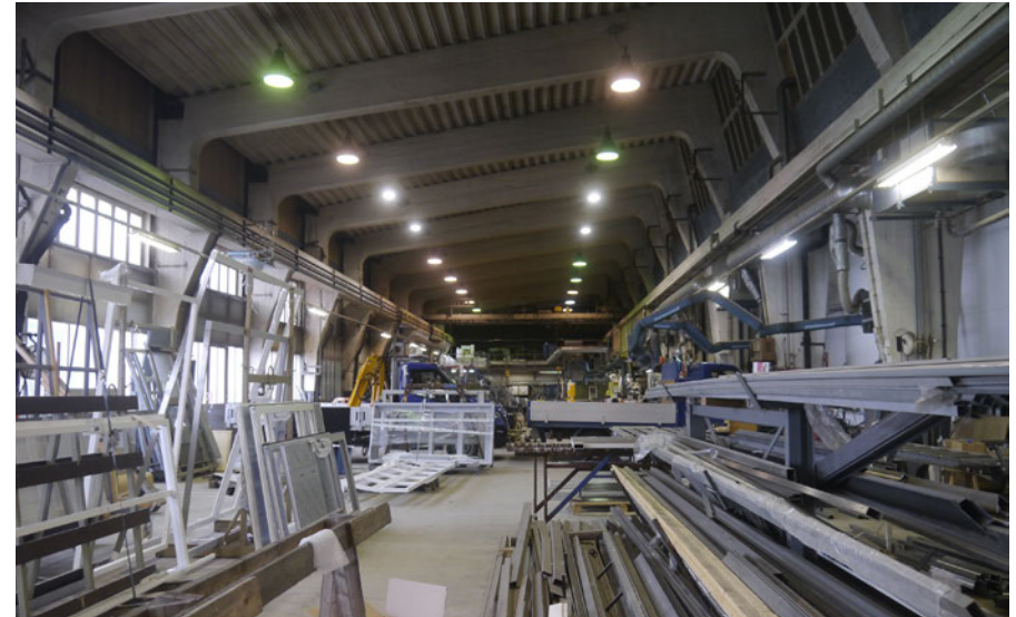
Konekorjaamon päähalli on pituussuunnassa yhteinaistä tilaa. Alkuperäiset kattorakenteet ovat näkyvillä.
