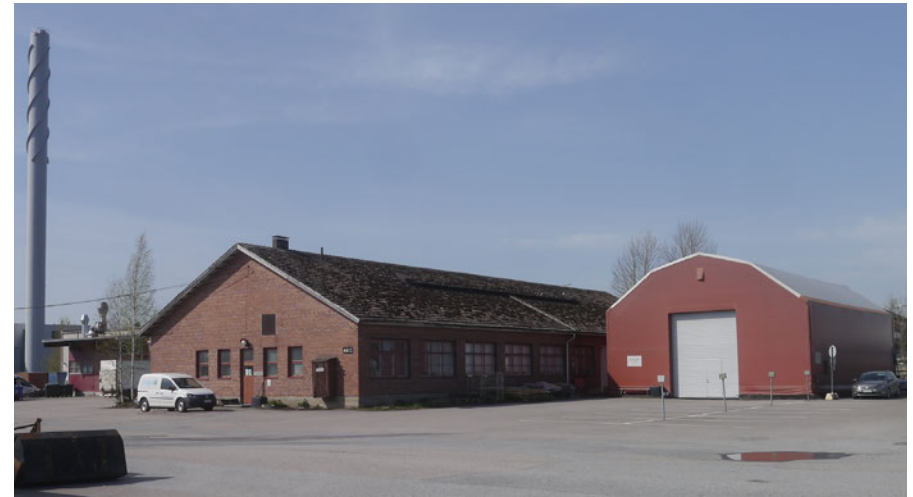
Puutyöpaja ja siihen liittyvä pressukatos kaakosta
