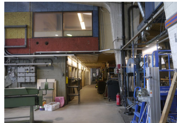
Työnjohdon ikkunat hallitilaan
