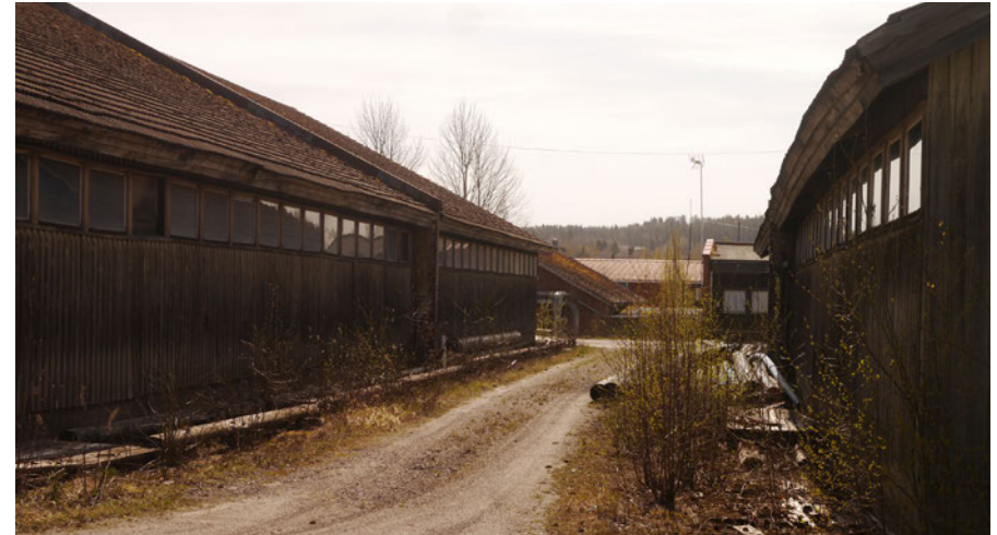
Varastojen C ja B välinen kuja
