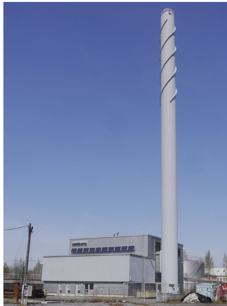
Sähkölaitoksen lämpökeskus kaakosta
