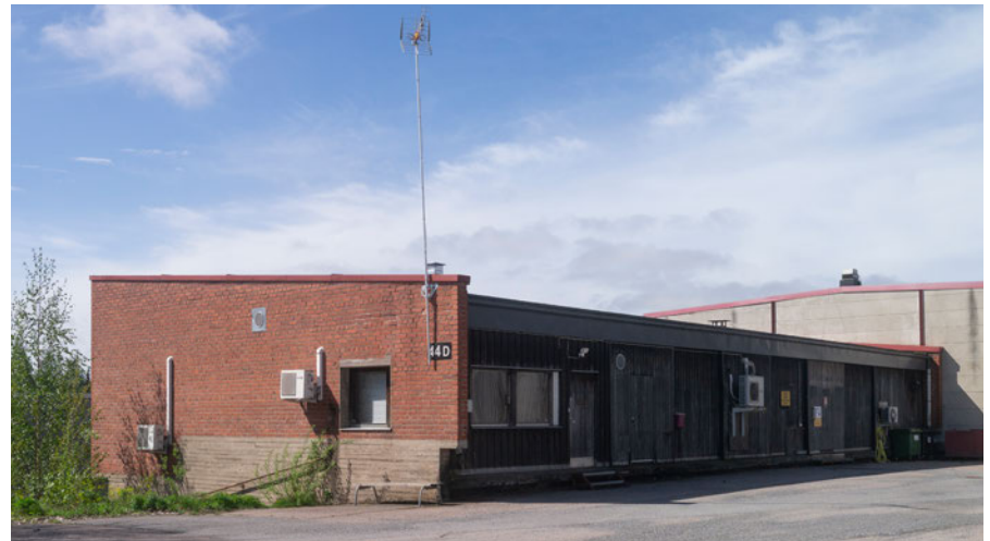
Alkuperäinen rakennusosa ja kulmaan vuonna 1984 lisätyt ikkunat
