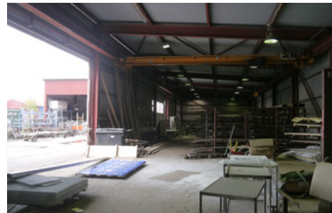
Konekorjaamon vuonna 1986 rakennettu länsisiipi. Taustalla vasemmalla vuoden 1999 lisäosa.
