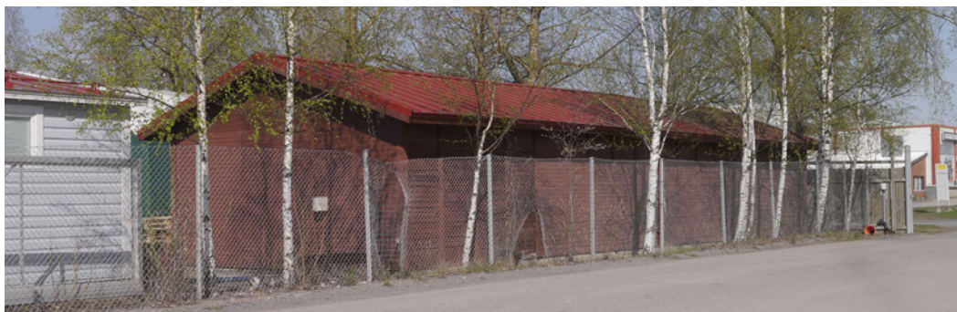
Jäteaseman varasto lounaasta
