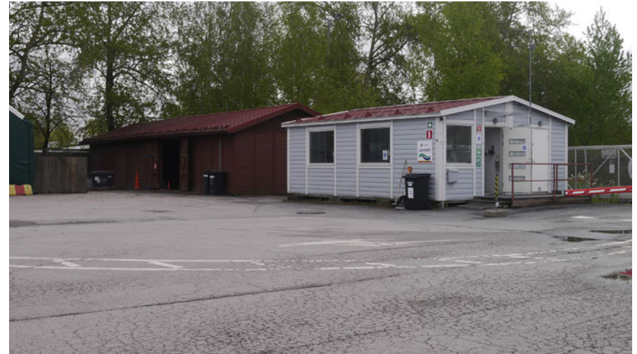
Jäteaseman toimisto sekä varistorakennus luoteesta
