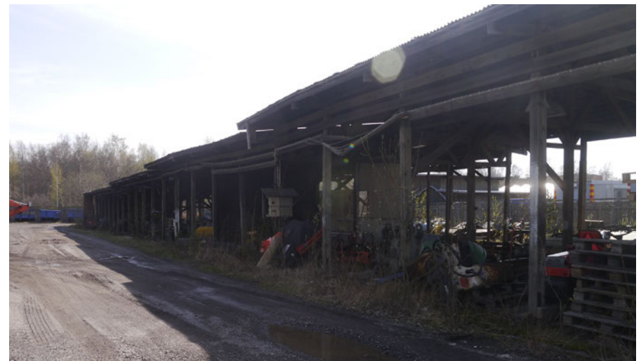
Katoksen itäinen julkisivu
